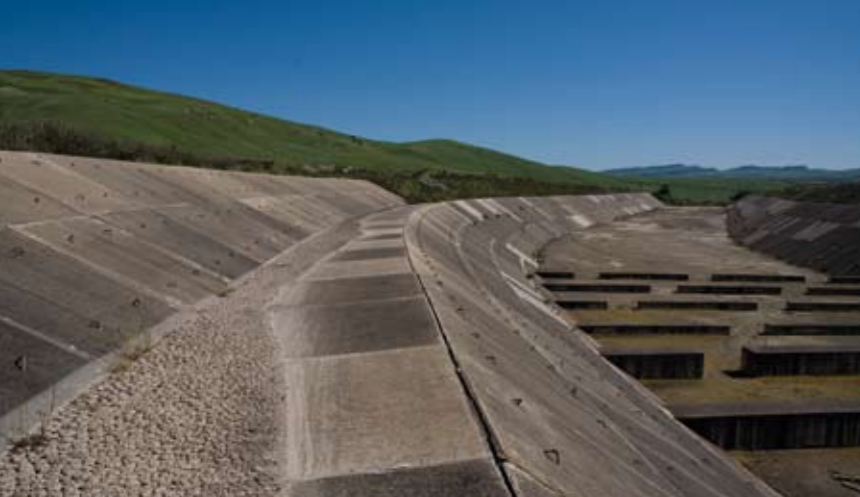
Blufi (Palermo). Diga / Dam
